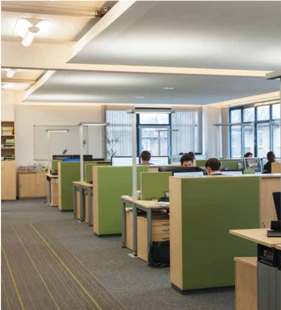
Zehnder Gipskartonsegel kühlen – im Gegensatz zur klassischen Umluftkühlung – durch Strahlungskühlung über Kühlelemente, die ohne großen Aufwand und optische Einschränkungen sehr praktikabel in jeder Decke integriert werden können.
