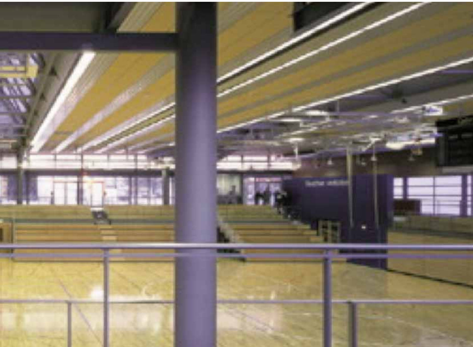
Sporthalle Rosenheim. Bündig in die Decke integrierte Zehnder Deckenstrahlplatten. Mit hochgezogenen Kopfstücken.
