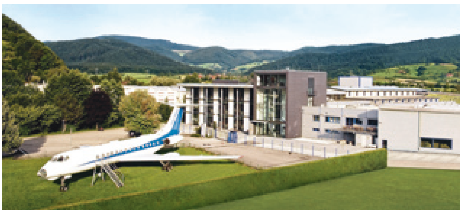
Der Baukörper des neuen Headquarters von Hydro, dem weltweit führenden Hersteller für Flugzeugbodengeräte, wurde optisch einem Flughafenterminal nachempfunden. Es verfügt über 1.000 m 2 Bürofläche und eine Besprechungsetage mit Panoramaterrasse.
