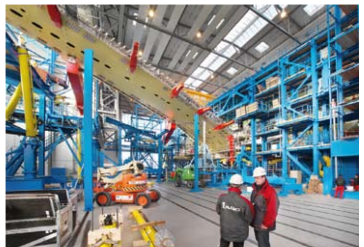
Energieeffizientes Beheizen einer Großanlage: Auch bei fast 30 Metern Hallenhöhe lässt sich mit den Strahlplatten sehr ökonomisch eine homogene Raumtemperatur erreichen.
