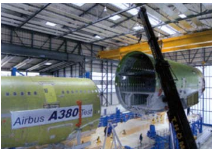
Nicht nur die Abmessungen des neuen Airbus 380 sind extrem. Für die knapp 30 Meter hohe Haupthalle fertigte Zehnder Deckenstrahlplatten mit einer Baulänge von jeweils 68 Metern.
