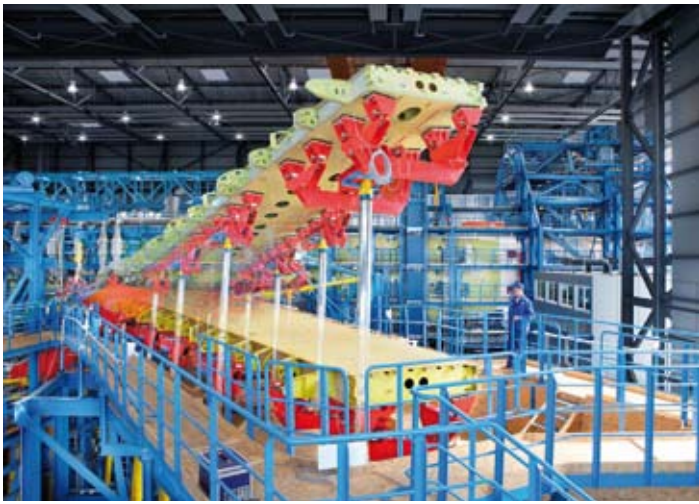
Zahlreiche Installationen auf dem Boden der Testhalle machten die Alternative einer Fußbodenheizung praktisch unmöglich. Deckenstrahlplatten hingegen erfüllen alle Anforderungen an Platzersparnis, wirtschaftlicher Effektivität und Heizergebnis.
